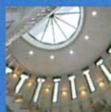
図書館吹抜け
