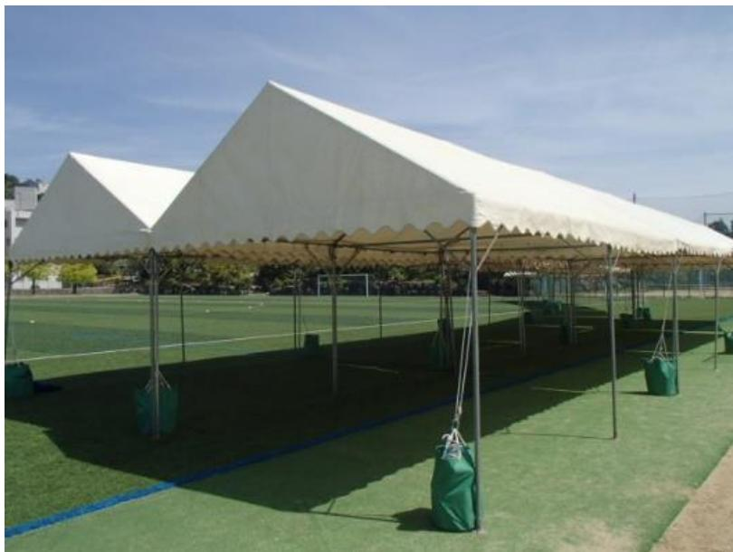
写真のように、ペットボトルを土嚢袋に入れロープで固定させます。
